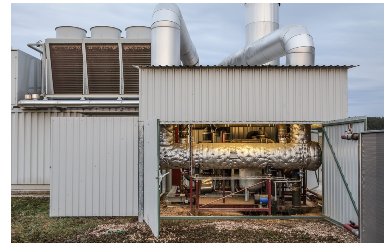
Kladruby u Radnic - izolace spalínového výměníku v technologii FLEXIZOL S
